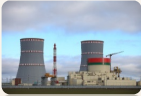
Другі энергаблок атамнай электрастанцыі
