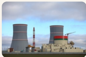
Второй энергоблок атомной электростанции
